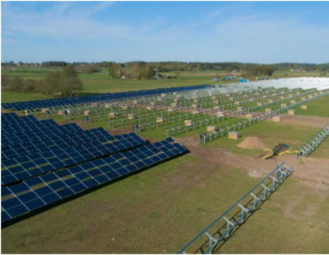
Figur 4 och Figur 5: Vänster: exempel på montage av solpaneler på markställningar. Anläggningen är Svea Solars solenergianläggning i Sjöbo (Bildkälla: Ny Teknik). Höger: Pålning av balkar med pålningsmaskin (foto: Magnus Fast, OX2).
