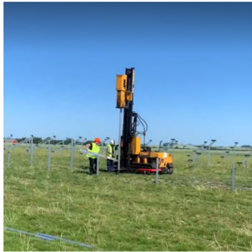
Figur 4 och Figur 5: Vänster: exempel på montage av solpaneler på markställningar. Anläggningen är Svea Solars solenergianläggning i Sjöbo (Bildkälla: Ny Teknik). Höger: Pålning av balkar med pålningsmaskin (foto: Magnus Fast, OX2).
