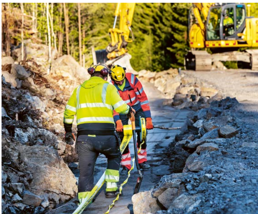
Byggnation av Ribäcken vindpark i Finland. Foto: Joachim Lagercrantz.
