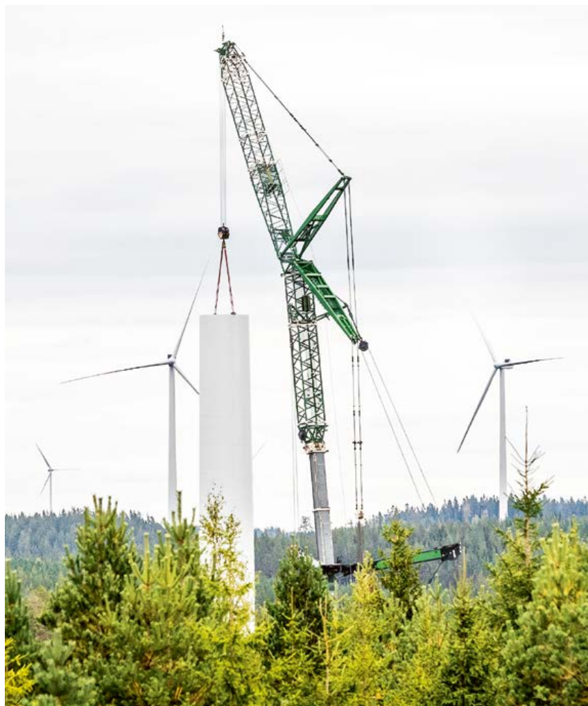
Byggnation av Åmot-Lingbo och Tönsen vindparker (366 MW) i Sverige. Foto: Joachim Lagercrantz
