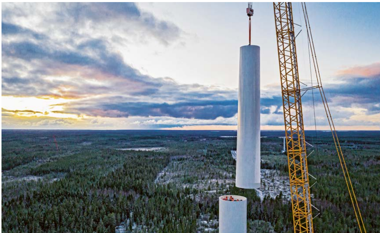
Byggnation av Långmossa vindpark i Finland. Vindparken ingår i projekt "Castles" (107,4 MW). Foto: Joachim Lagercrantz.
