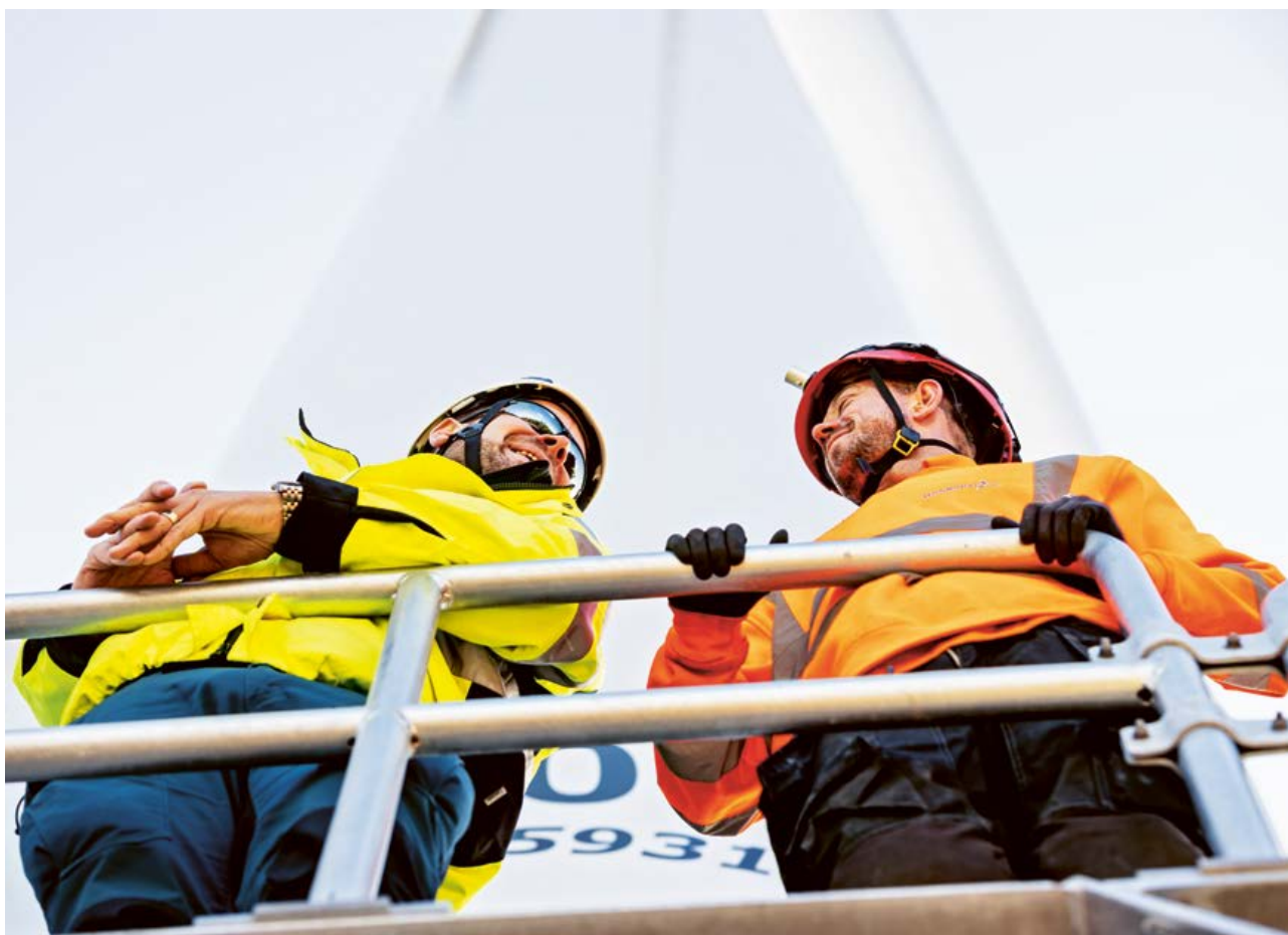
Samarbete i leverantörskedjan under byggnation av Orrberget vindpark (33 MW) i Sverige. Foto: Joachim Lagercrantz
