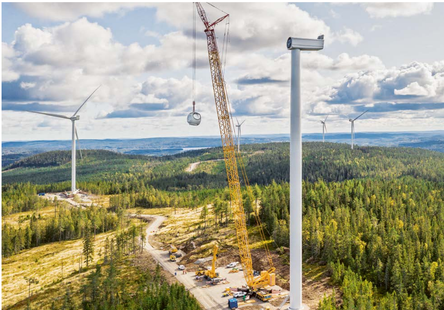
Byggnation av Orrberget vindpark (33 MW) i Sverige. Foto: Joachim Lagercrantz
