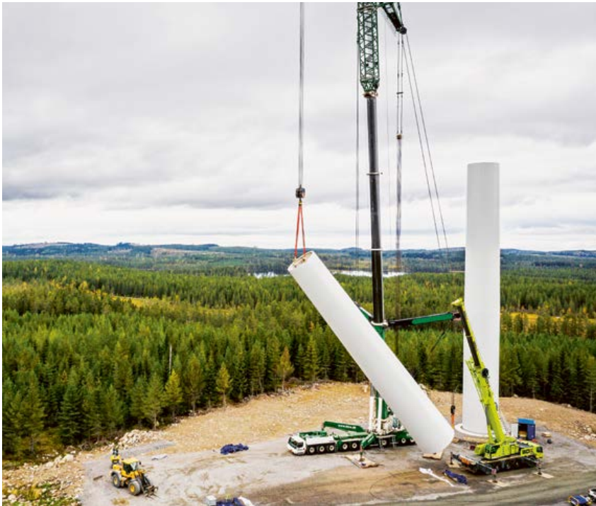
Montering av vindkraftverk i Åmot-Lingbo och Tönsen vindparker (366 MW). Foto: Joachim Lagercrantz
