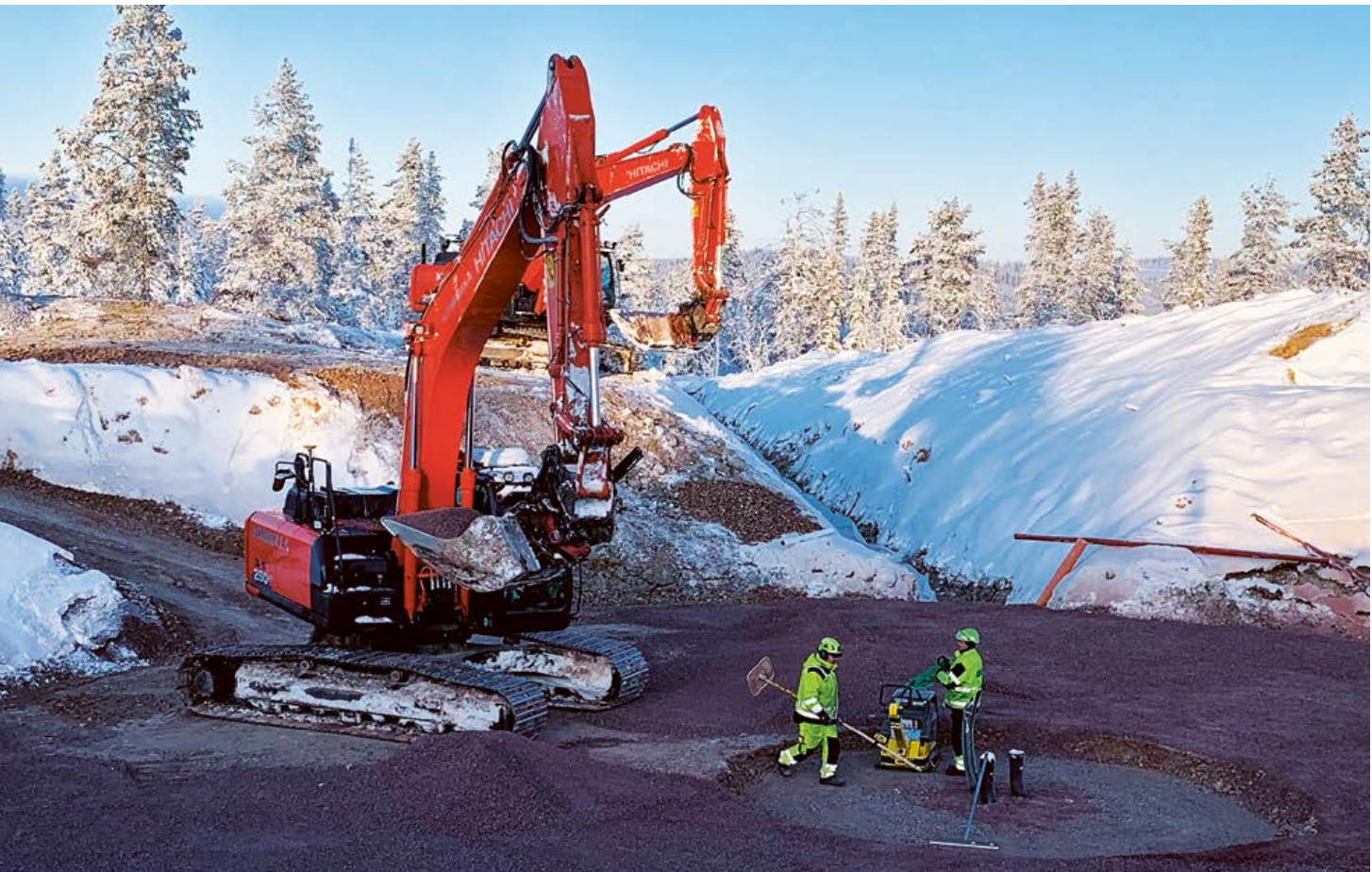
Arbete med vindkraftsfundament i Åndberg vindpark (286 MW) Foto: OX2
