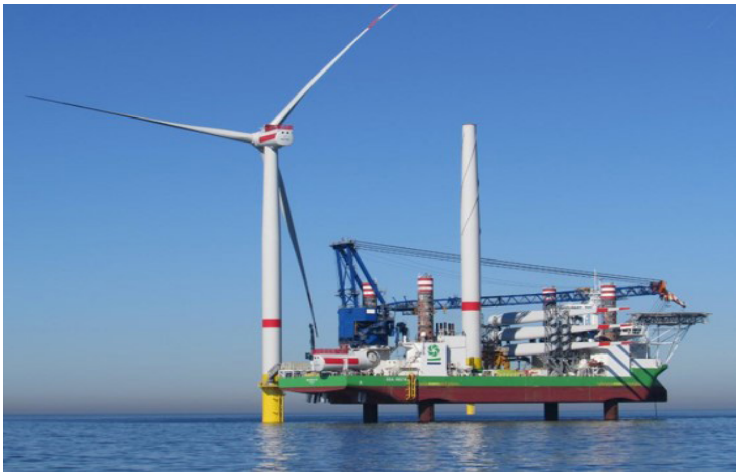
Figur 15 Montering av vindkraftverk med ett fartyg av typen jack-up. Källa: COWI
